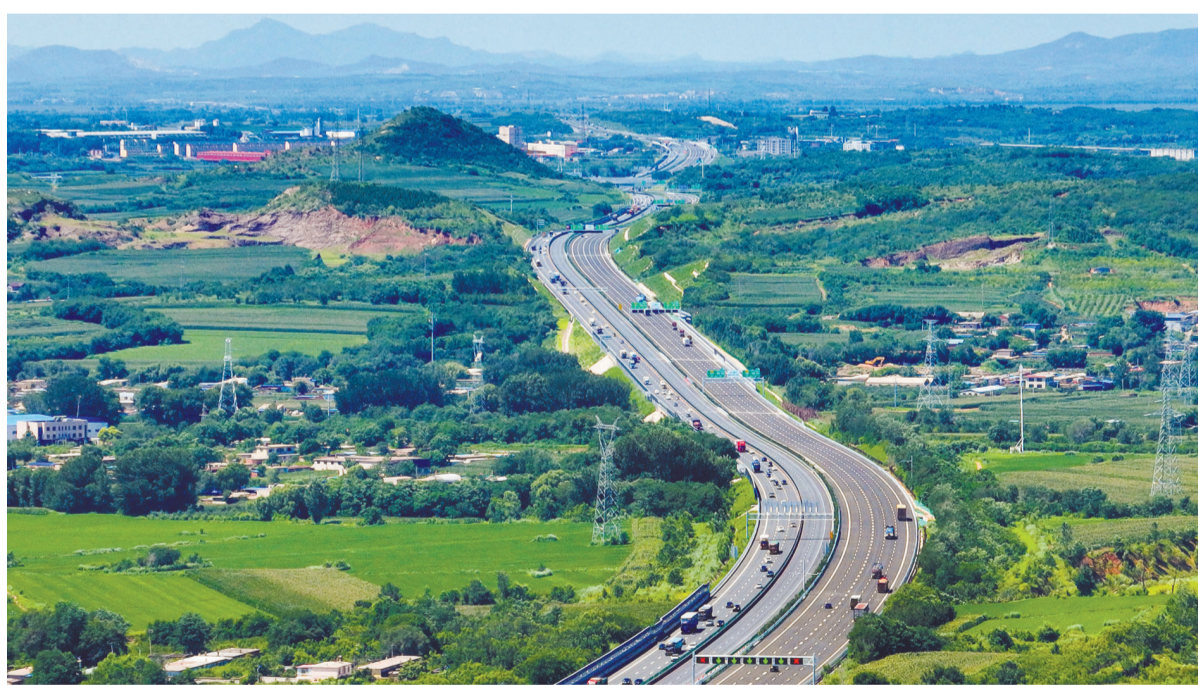
京哈高速改扩建工程将于9月底前全线贯通。图为京哈高速改扩建工程锦州段。本报记者 查金辉 摄
