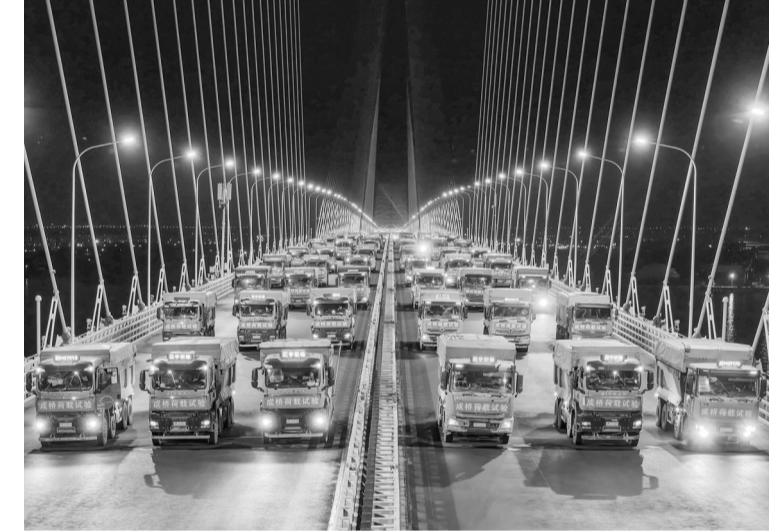
6月20日,参与荷载试验的重型卡车有序排列在常泰长江大桥主航道桥上(无人机照片)。6月20日晚,常泰长江大桥主航道桥进行4400吨荷载试验,110辆重型卡车驶上主航道桥面,启动静态荷载试验。自6月16日起,常泰长江大桥开启为期一周的荷载试验,对大桥承载力和安全性进行全面评估。
