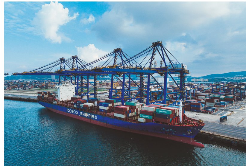
图为大连集装箱码头装卸现场。
