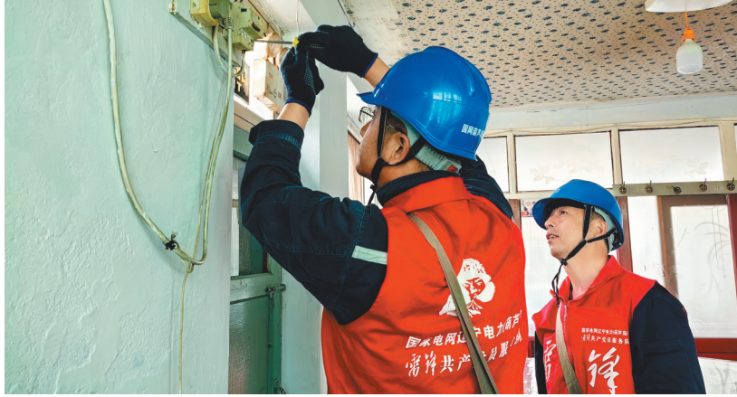
国网葫芦岛供电公司员工开展用电隐患排查,确保百姓温暖过冬。 芦锦凤 摄
