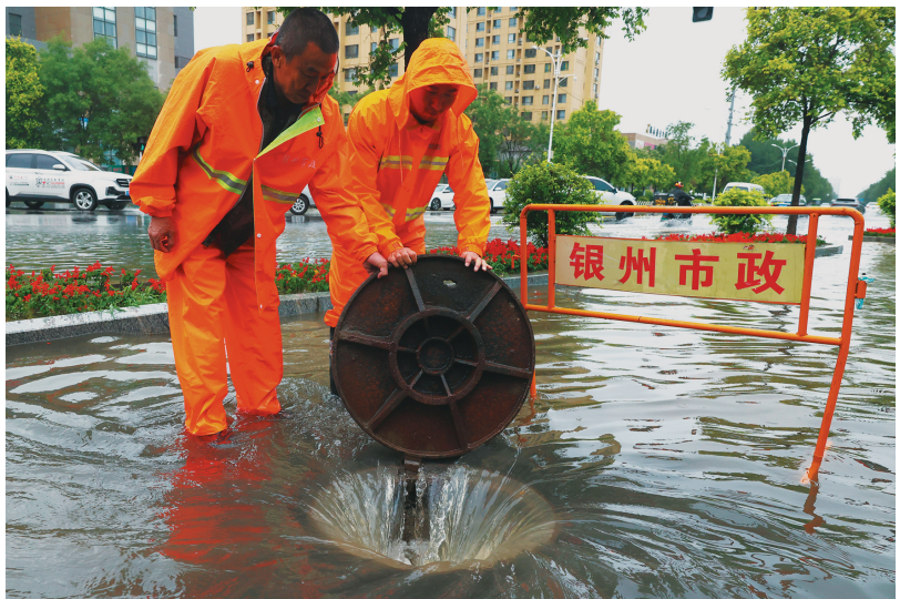
铁岭市银州区市政工作人员在水中查看排水情况。本报特约记者 桂铁军 摄
