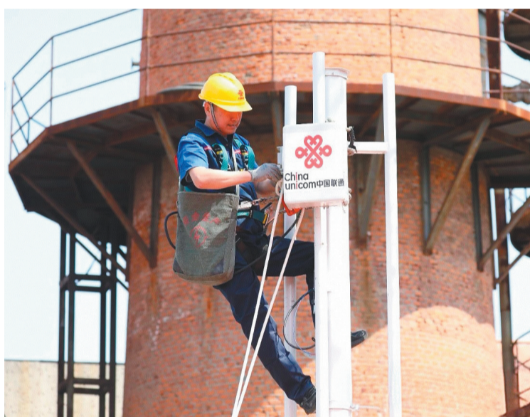
辽宁联通工作人员正在检修网络线路。
