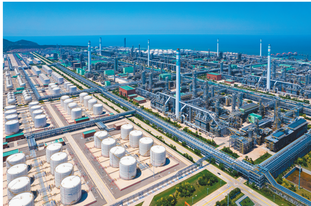
图为俯瞰恒力(大连长兴岛)产业园。
