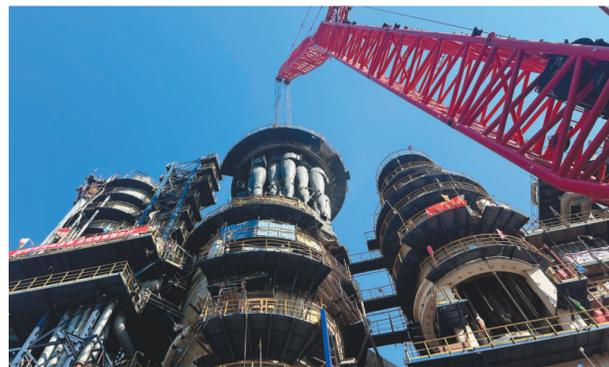
6月16日10时,大连西太平洋石化公司的检修过程中,抚顺石化公司一次成功拆除重达340吨的催化装置第一再生器锥段及旋风加汽提段,标志着催化第一再生器改造工程拆除基本完成。这是今年中国石油集团公司检修吊装作业中最重的一吊。为实现安全
