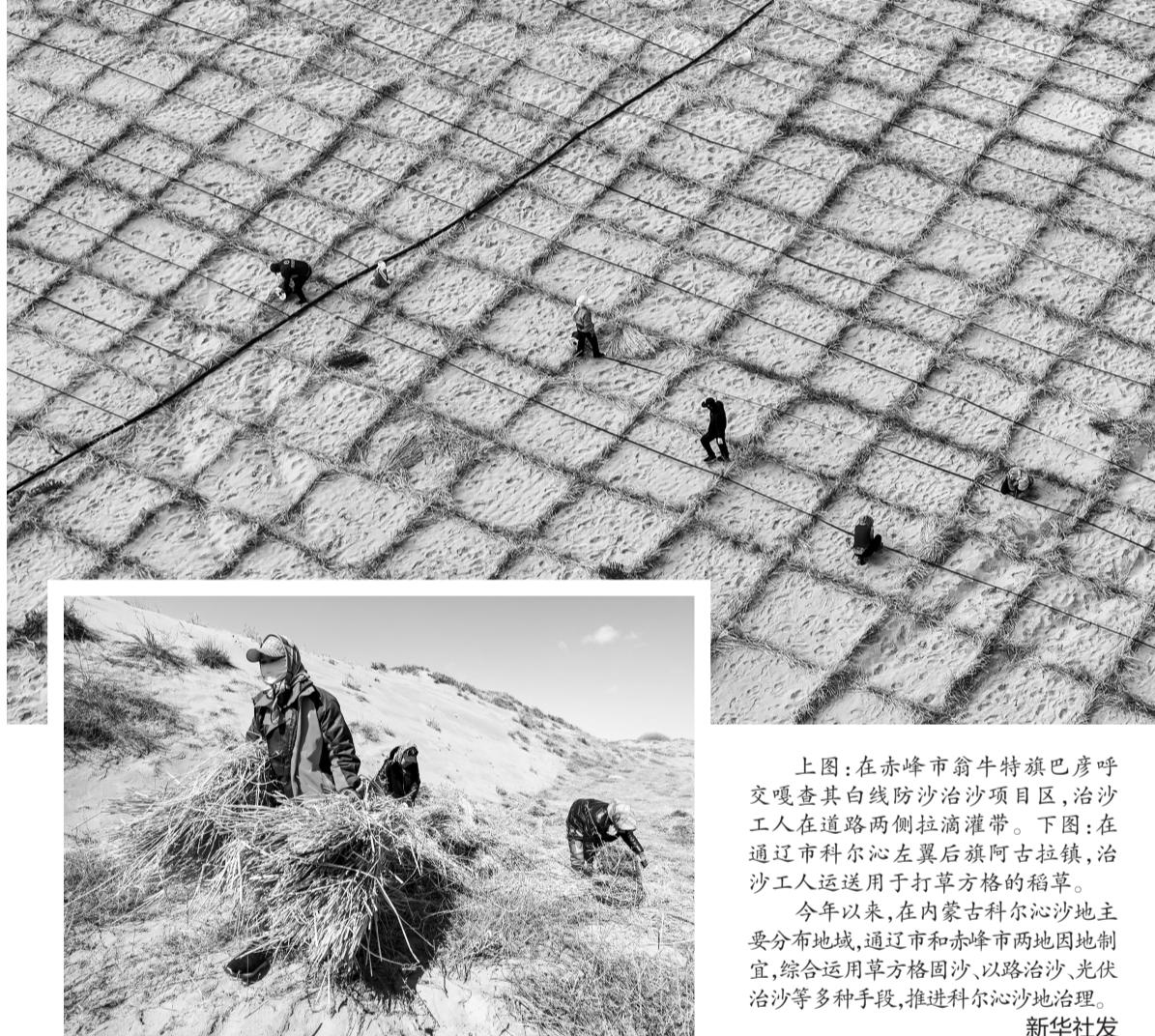
上图:在赤峰市翁牛特旗巴彦呼查嘎查其白线防沙治沙项目区,治沙工人在道路两侧拉滴灌带。下图:在通辽市科尔沁左翼后旗阿古拉镇,治沙工人运用打草方格的稻草。
