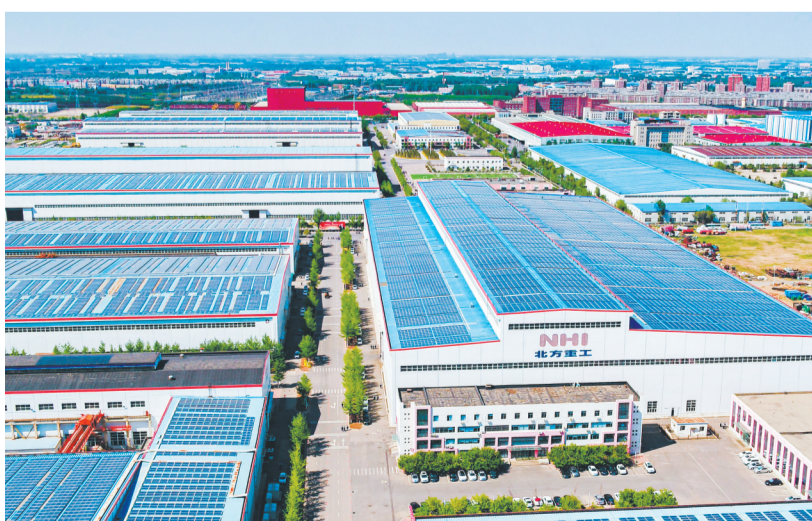
北方重工厂房屋顶的太阳能发电设备年均发电量超过2500万千瓦时。 王宏涛 摄
