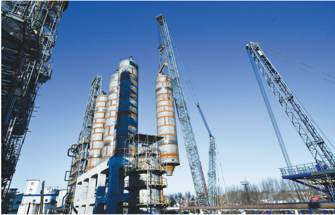
锦州石化40万吨/年针状焦装置项目现场吊装焦炭塔。
