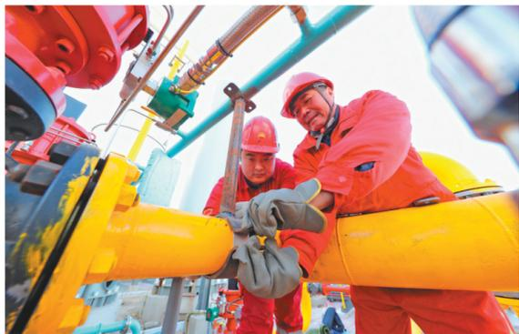
辽河油田双229块CCUS循环注入站脱烃装置准备进行吸附剂吹扫,工人正在进行投产前最后的准备。
