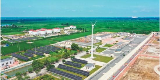
辽河油田油气集输公司坨子里输油站利用光能与风能生产“绿电”,实现了清洁能源替代。
