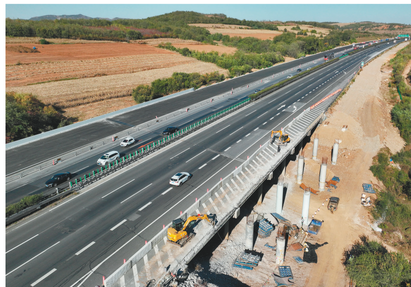
建设中的京哈高速改扩建工程锦州南口与丹锡高速交会处。
