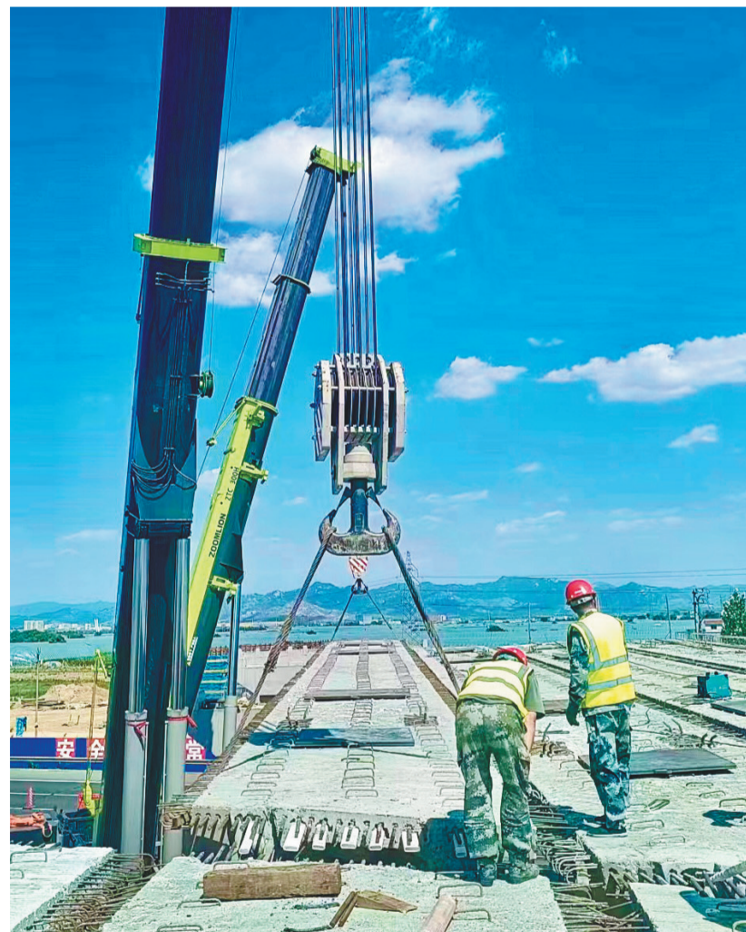
仙人岛疏港高速公路建设现场，建设者正在进行跨线桥施工。
