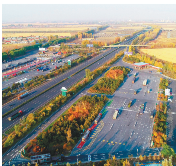
俯瞰沈大高速公路井泉服务区。 本报记者 杨靖岫 摄
