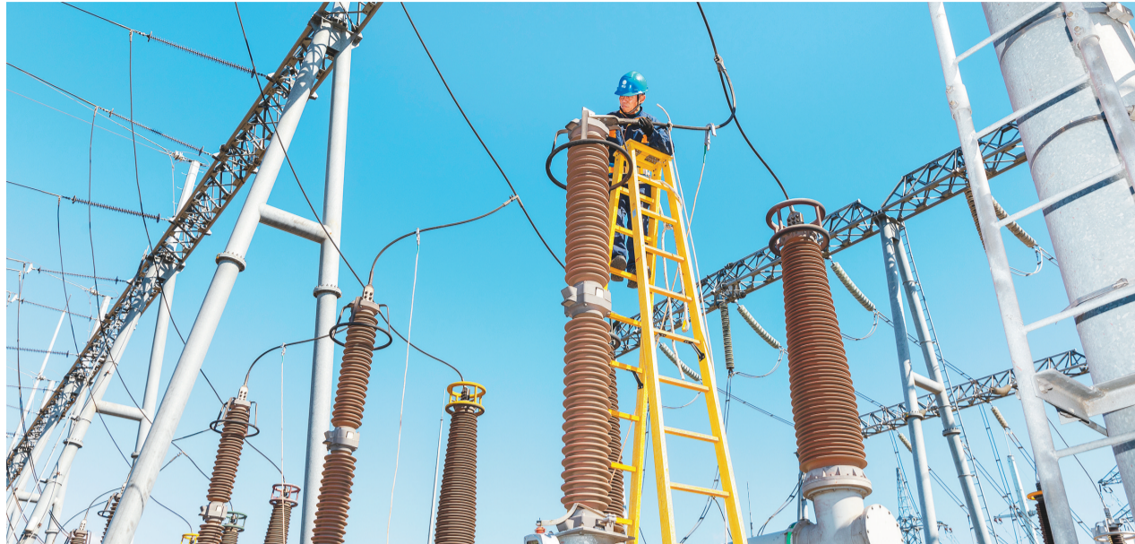
鞍山供电公司员工对220千伏王铁变电站220千伏王牵二线避雷器开展隐患排查,提升变电站冬季供电保障能力。 赵琦林 摄
