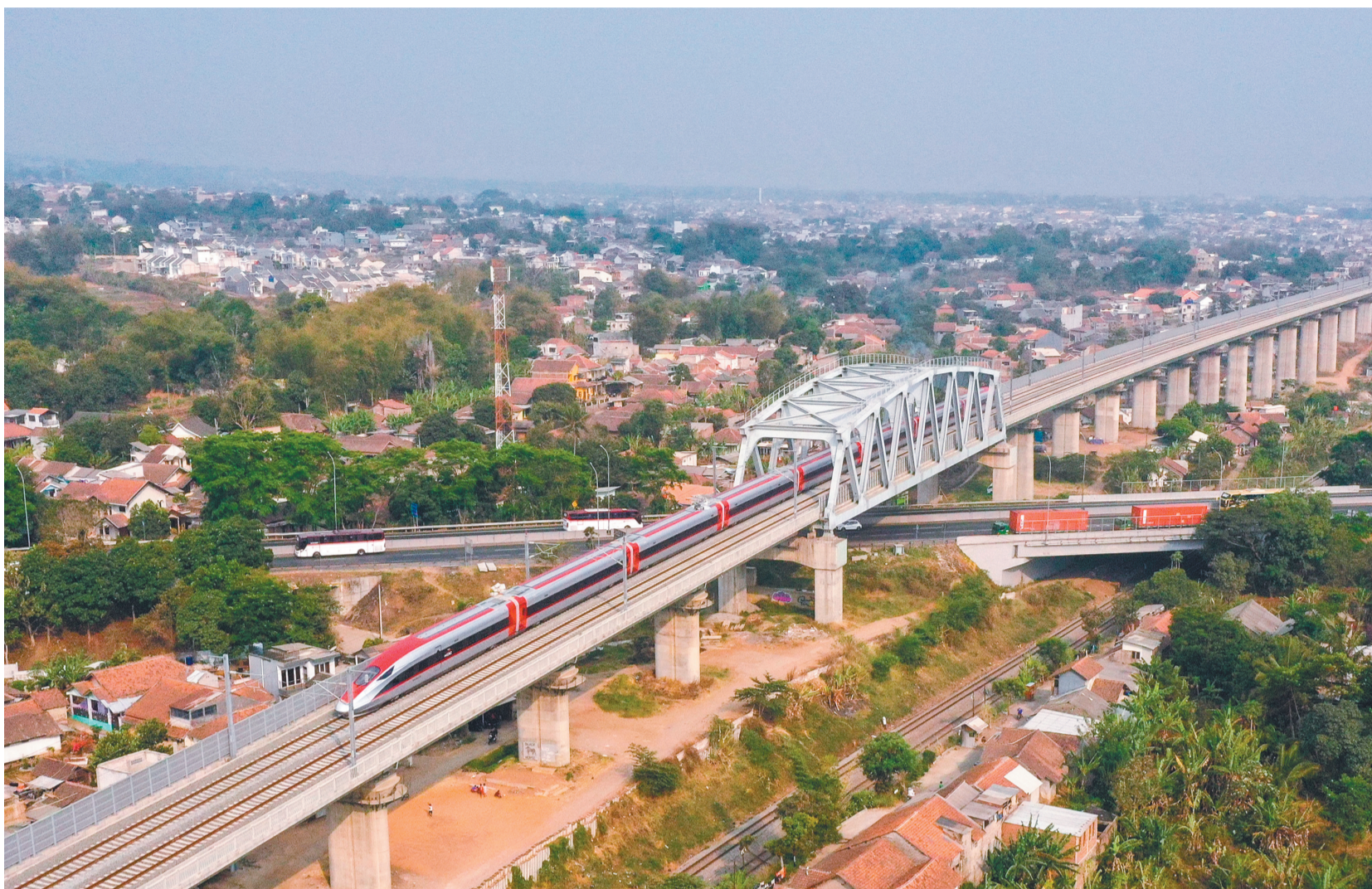
这是9月30日在印度尼西亚帕达拉朗拍摄的一列行驶中的雅万高铁高速动车组(无人机照片)。
