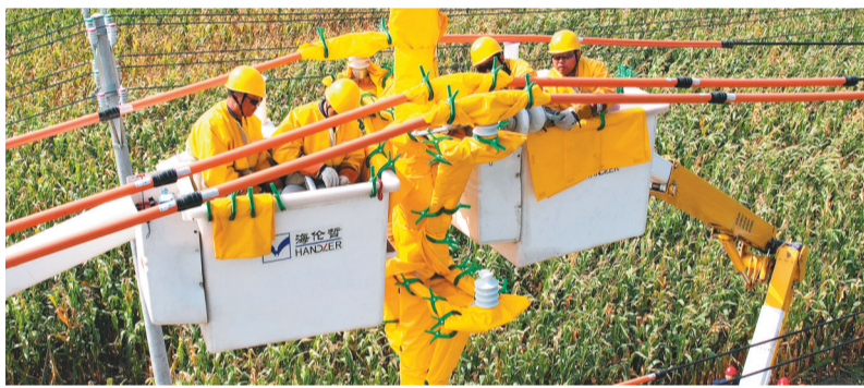
国网阜新供电公司员工正在进行直线杆改耐张杆带电作业。 徐海亮 摄
