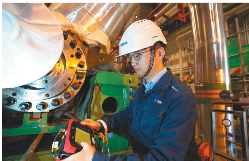
红沿河核电站工作人员正在进行设备检修。 何鹏 摄
