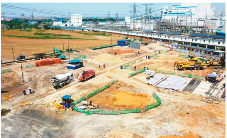
国电投清河发电500千伏主变扩建工程项目建设现场。
