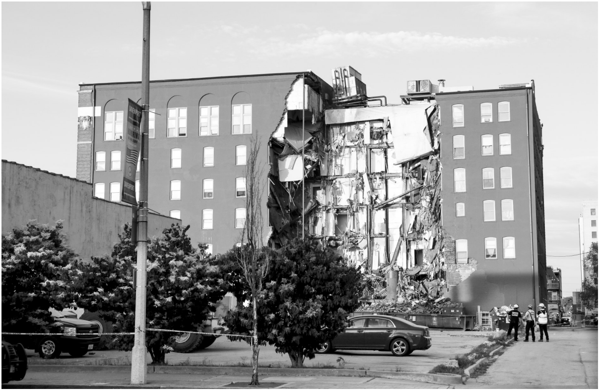
这是5月28日在美国艾奥瓦州达文波特拍摄的建筑物坍塌现场。据外媒报道,28日,美国艾奥瓦州达文波特的一栋建筑物部分坍塌,目前伤亡情况不明。新华社发
