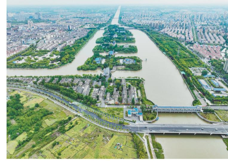
5月7日在江苏省扬州市拍摄的江都水利枢纽(无人机照片)。江都水利枢纽位于江苏省扬州市境内京杭大运河、新通扬运河和淮河入江水道交汇处,南濒长江、北连淮河,是南水北调东线工程的源头,被誉为“江淮明珠”。该枢纽主要由4座大型电力抽水站、12座大中型水闸、3座船闸以及输变电工程、引排河道等组成,共装机33台套,容量55800千瓦,是目前我国规模最大的电力排灌工程、亚洲最大的泵站枢纽。
