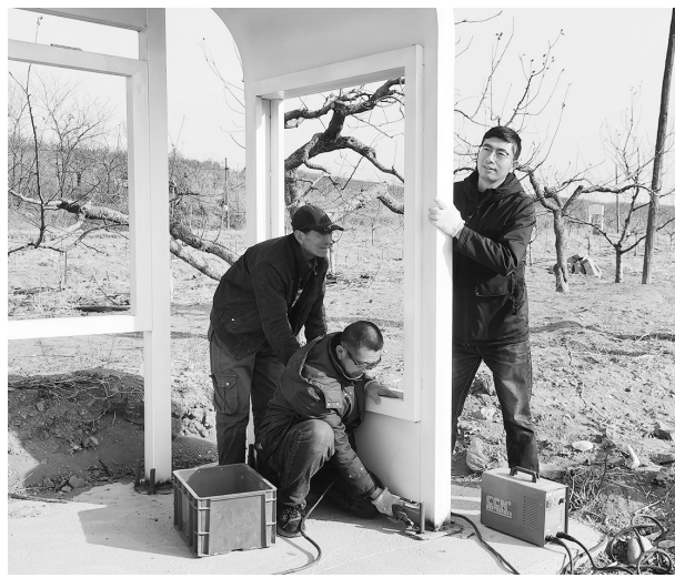
瓦房店市李官镇曲家村驻村第一书记刘春雷(右一)在学生候车亭施工现场。
