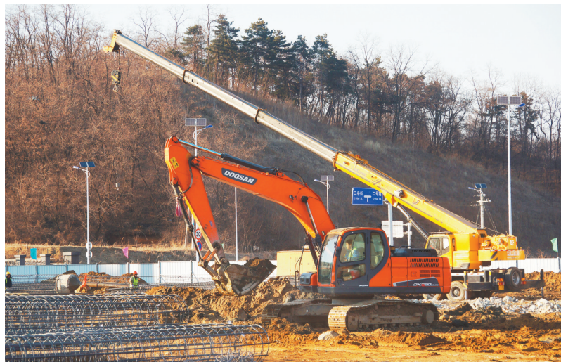
坐落于抚顺市高新区的辽宁祥顺气体有限公司稀有气体精制项目施工现场。
