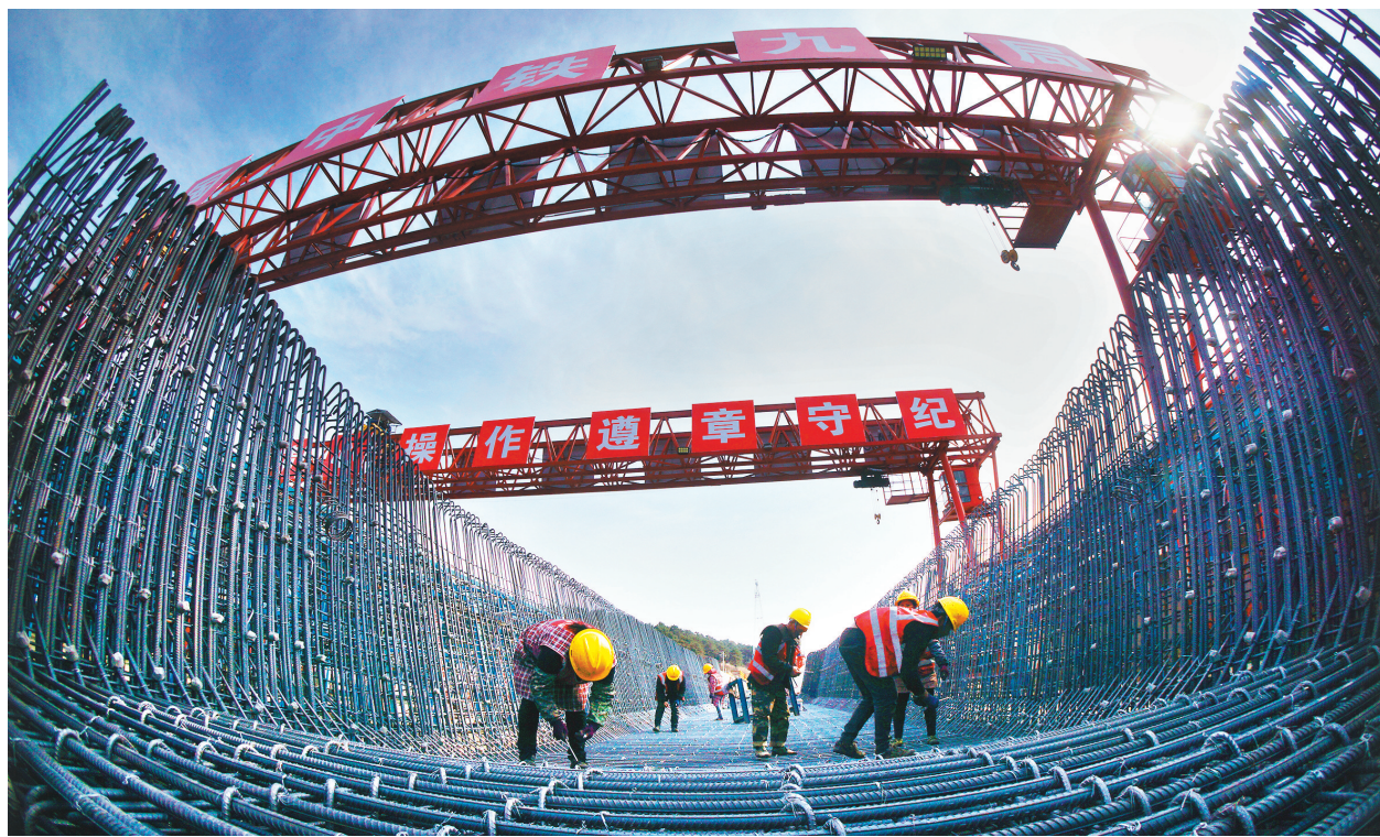
在位于抚顺市东洲区兰山乡的沈白高铁建设工地上,工人正在加紧施工。
