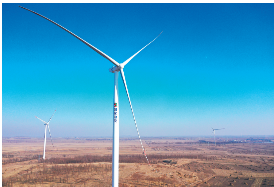
黑山县风电项目实现首批风机并网发电。
