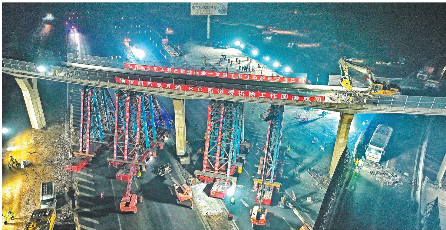
京哈高速公路改扩建工程施工现场。
