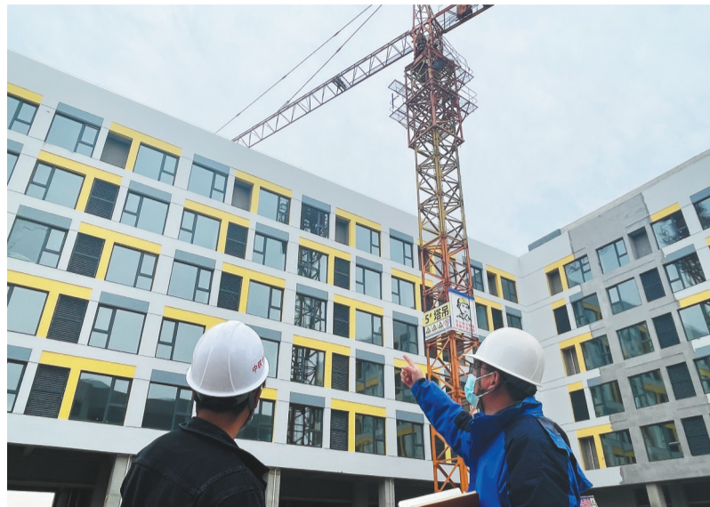
锦州数字城一期项目施工现场。 本报记者 崔治 摄
