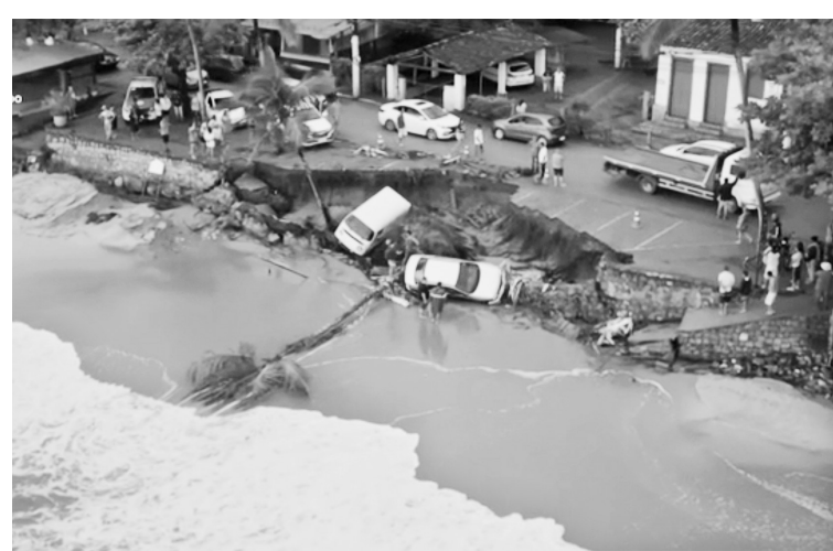
这张巴西圣保罗州政府提供的照片显示，2月19日，圣保罗州东部的一处路面被暴雨破坏。巴西东南部圣保罗州政府19日说，该州沿海地区连降暴雨，引发洪水和山体滑坡等灾害，已致36人死亡。天气预报显示强降雨天气将持续，因灾死亡人数恐进一步上升。新华社发
