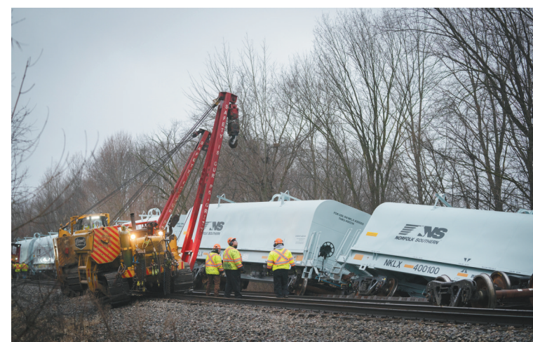
2月16日,应急人员在密歇根州范比伦镇的货运火车脱轨事故现场工作。美国一列货运列车16日在密歇根州范比伦镇脱轨。货运列车中装有危险化学品液态氯,所幸所在车厢没有脱轨,而脱轨的数节车厢中没有危险物品。 新华社发
