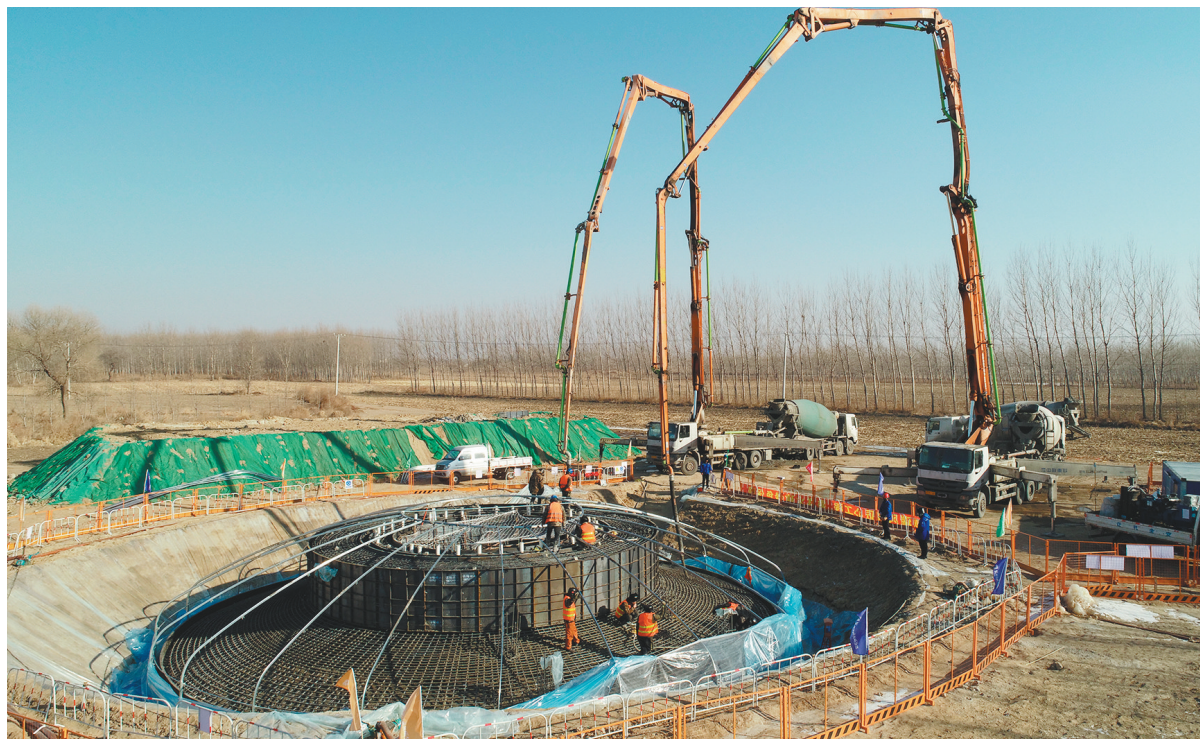
图为国家电投东北公司鞍山台安百万千瓦级新能源基地项目风机基础浇筑现场。
