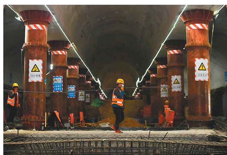
1月25日,中建三局西北公司工人在西安地铁8号线建设项目工地施工。西安地铁8号线是西安市轨道交通网中的骨干线路。节日期间,西安地铁8号线施工现场一派繁忙景象,建设者们坚守一线,抢抓工期,保障施工进度。新华社发
