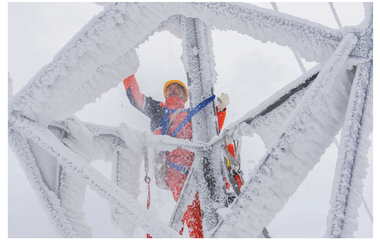
1月17日,在湖北省鹤峰县山区,应急抢险人员在铁塔上除冰雪。寒潮来袭,地处湖北省西南部的鹤峰县出现雨雪降温天气,高山地区电力设施覆冰积雪严重。当地组织应急抢险人员及时进行除雪作业,保障输电线路安全运行,守护万家灯火。
