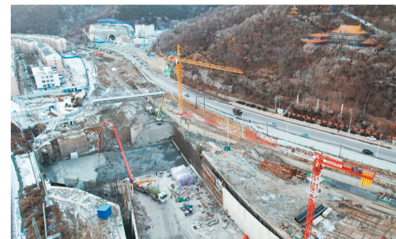
数九寒冬，沈白高铁建设仍在进行中。
