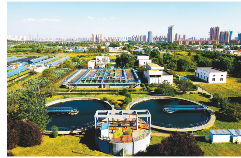
国家能源集团东陵污水处理厂生活污水处理现场。
