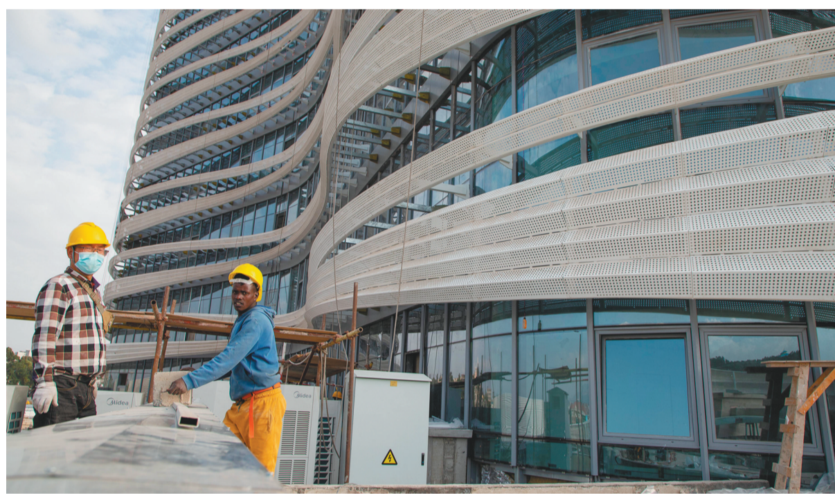
12月23日,在埃塞俄比亚首都亚的斯亚贝巴,工作人员在非洲疾病控制与预防中心总部大楼项目工地上工作。中国援非的非洲疾控中心总部一期项目于2020年12月开工。项目建成后,将成为非洲大陆第一所拥有现代化办公和实验条件,设施完善的全非疾控中心。 新华社发
