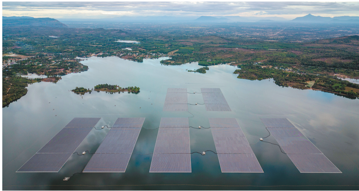
这是12月8日在泰国乌汶府诗琳通水库拍摄的浮体光伏项目(无人机照片)。中泰两国联合修建的泰国目前最大的浮体光伏项目自去年10月投入商业运营以来,这些中国制造的电池板不断将日光转化为清洁能源,输送至千家万户。 新华社记者 王腾 摄
