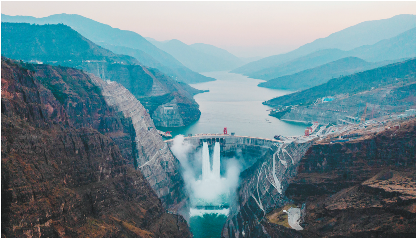
12月20日，金沙江白鹤滩水电站最后一台机组顺利完成72小时试运行，正式投产发电。至此，世界技术难度最高、单机容量最大、装机规模第二大水电站——白鹤滩水电站全部机组投产发电。 白鹤滩水电站位于四川省宁南县和云南省巧家县交界的金沙江干流河段上，总装机容量1600万千瓦，是我国实施“西电东送”的国家重大工程，共安装16台我国自主研发的全球单机容量最大功率百万千瓦水轮发电机组。 新华社发
