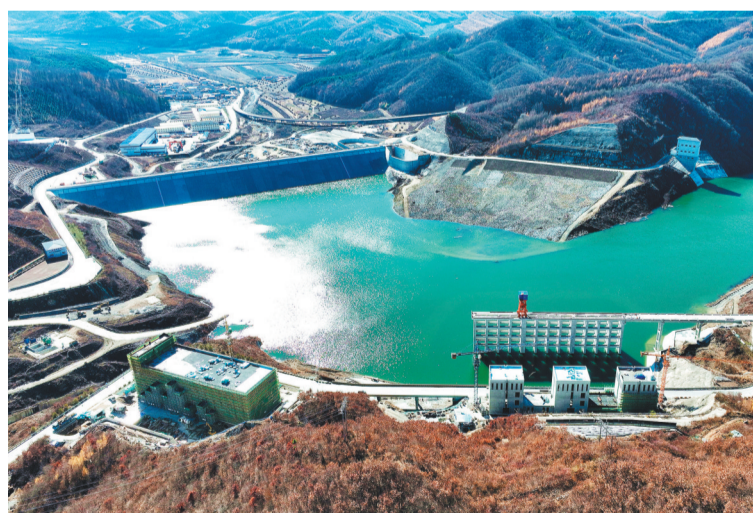
清原抽水蓄能电站项目建设现场。图片由清原县委宣传部提供
