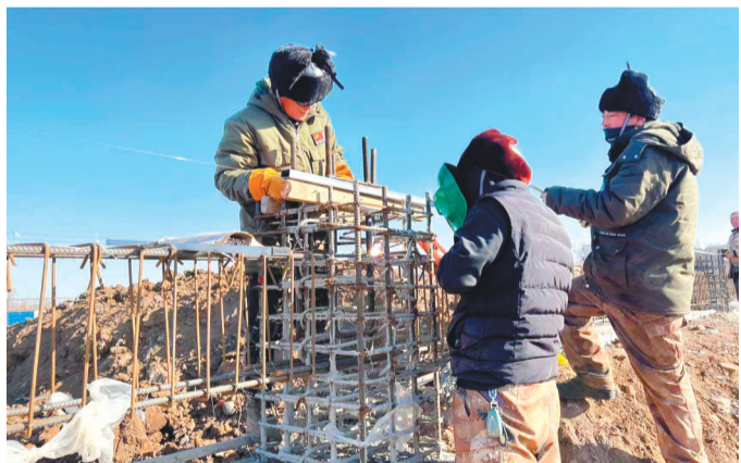
在辽阳冷链物流项目建设工地上,工人正冒严寒紧张施工。
