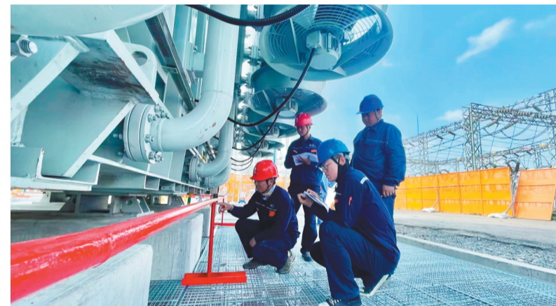
国网盘锦供电公司员工检查企业新更换的变压器。
