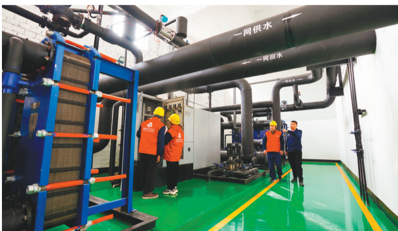
国网铁岭供电公司工作人员对调兵山市润鑫热力有限责任公司供电设备进行安全检查。
