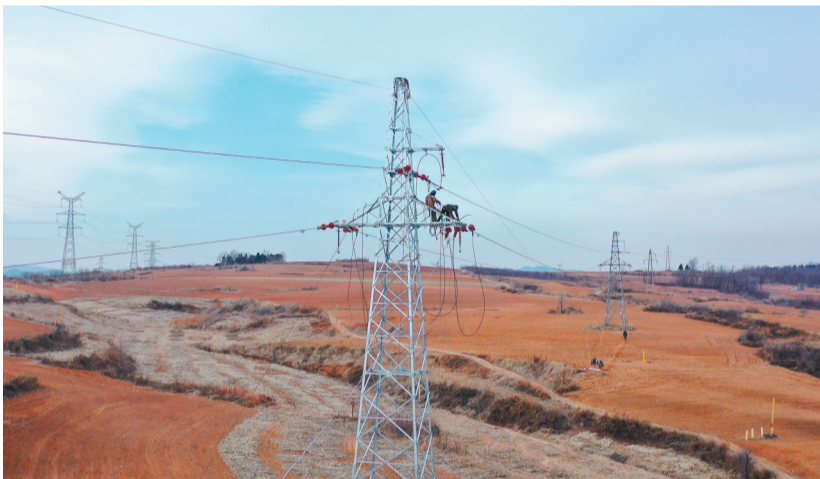
国网葫芦岛供电公司员工在220千伏沙西二线进行作业。
