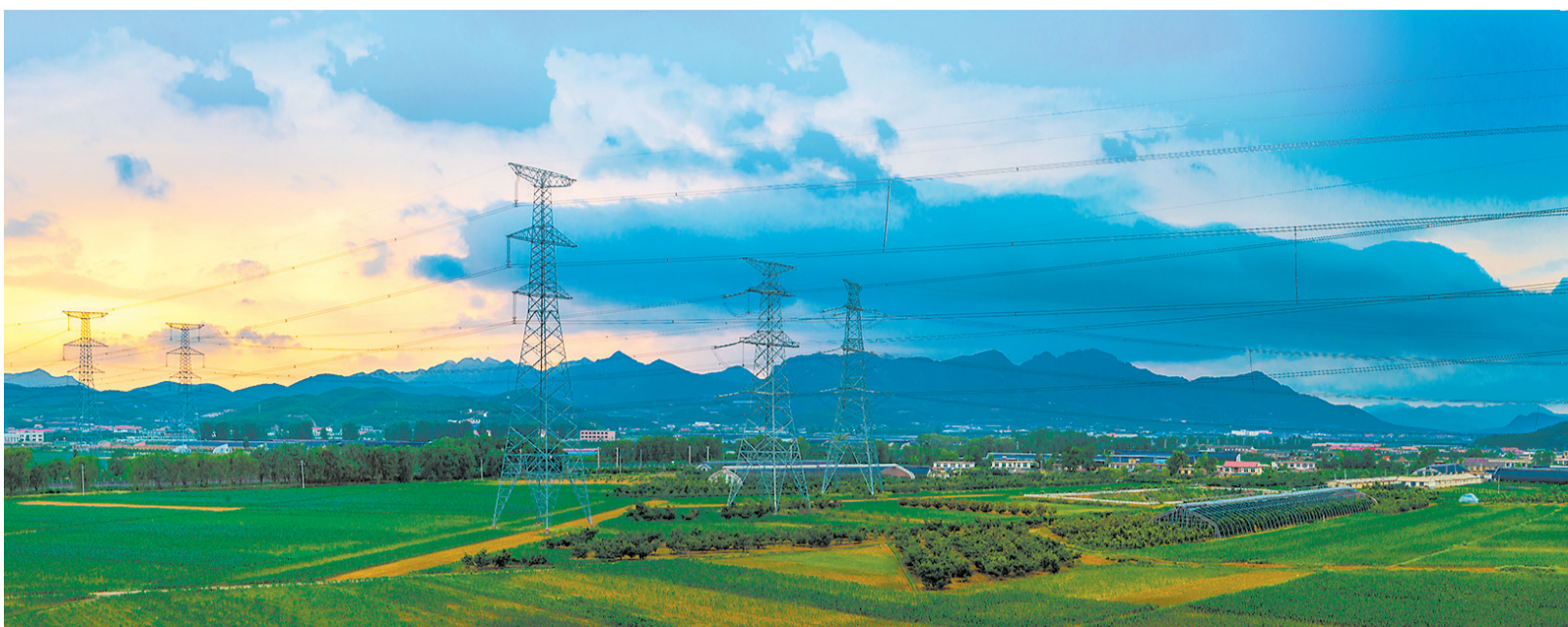
大连瓦房店地区500千伏输电线路。
