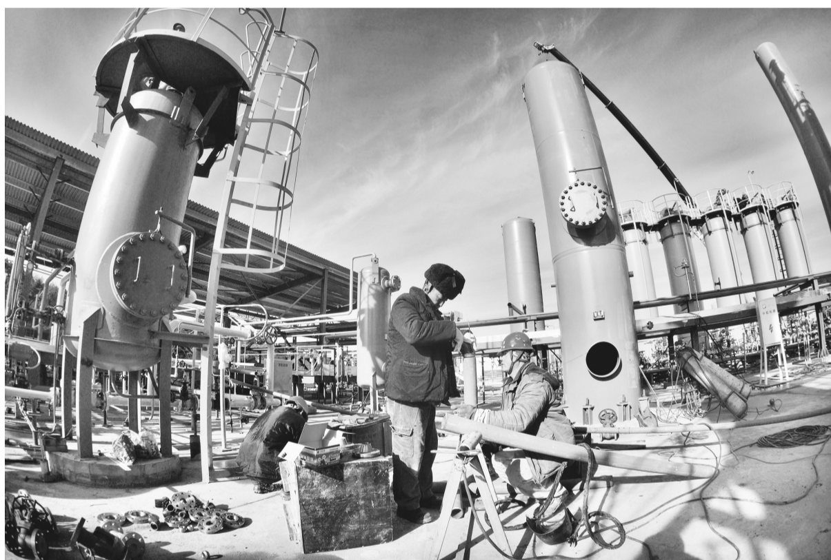
冬季施工忙 寒冬已至,但在抚顺市辽宁昆仑汉兴氢能科技有限公司日产36万立方米氢气项目建设现场,各个作业点却呈现一派热火朝天的繁忙景象。据介绍,该项目总投资3.1亿元,达产后能为抚顺高新区企业提供基础配套,目前项目建设已进入冲刺阶段。 本报特约记者 门莹 摄
