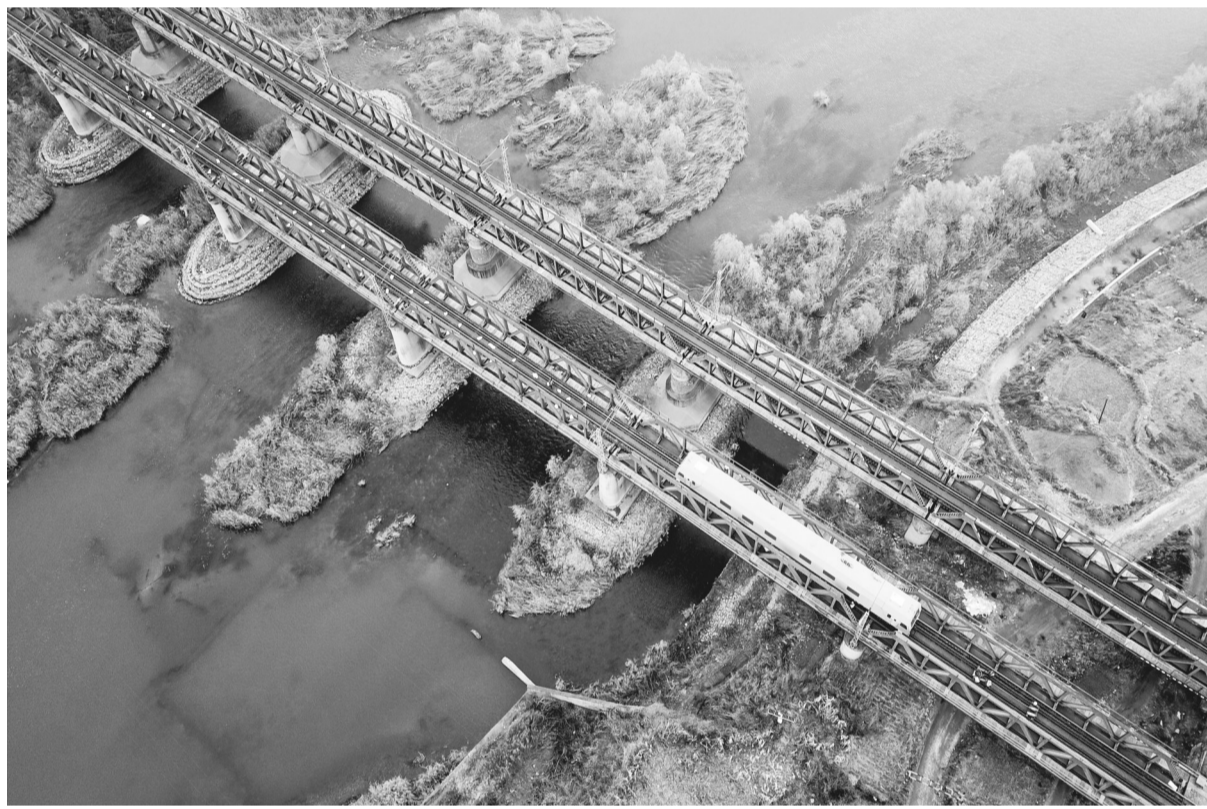
图为集中修会战施工现场。
