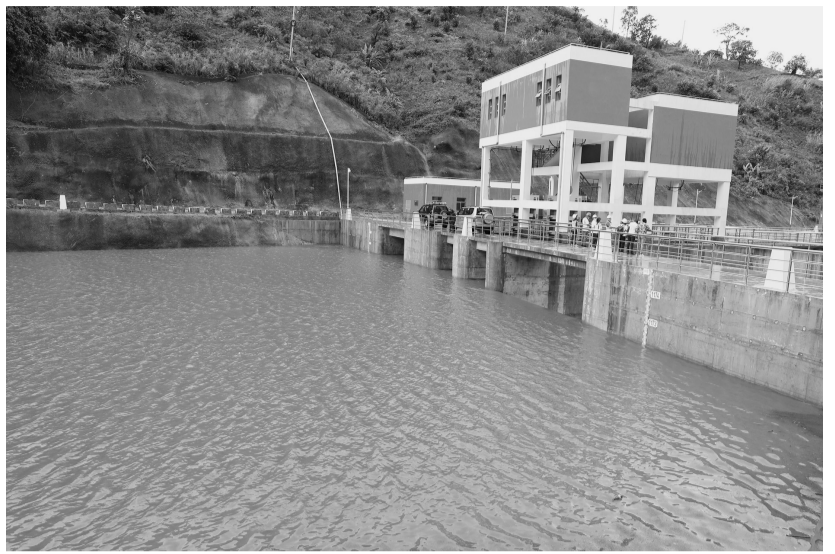
10月30日在布隆迪鲁齐巴齐村拍摄的鲁齐巴齐水电站大坝。中国援建的布隆迪鲁齐巴齐水电站最后一台机组于今年7月完成试运行,电站三台机组当月实现并网发电目标。水电站的建成对提高当地工业生产、促进国民经济发展、改善居民生活水平等起到重要作用。新华社记者 董江辉 摄
