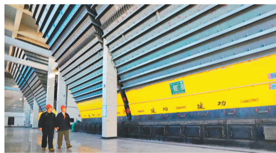
锦州热力集团投入资金近亿元,完成了热源、管网、泵站等设备检修工作。 本报特约记者 蔡壮 摄
