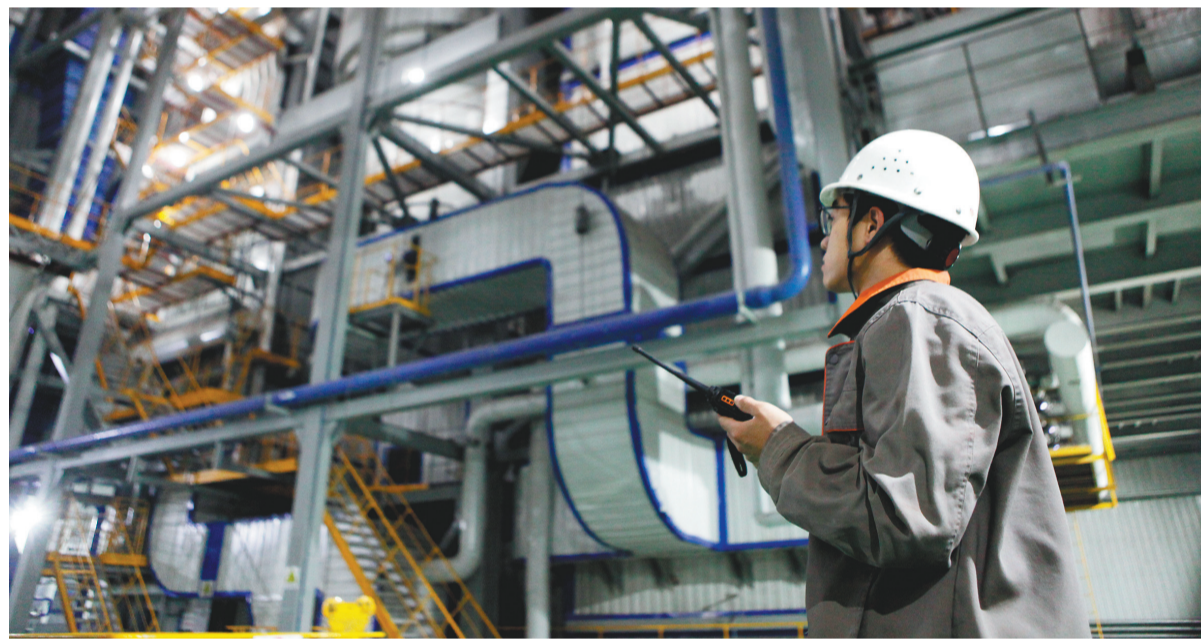
沈阳北方联盟热电有限公司工作人员在正式供热前巡查锅炉等供热设备。
