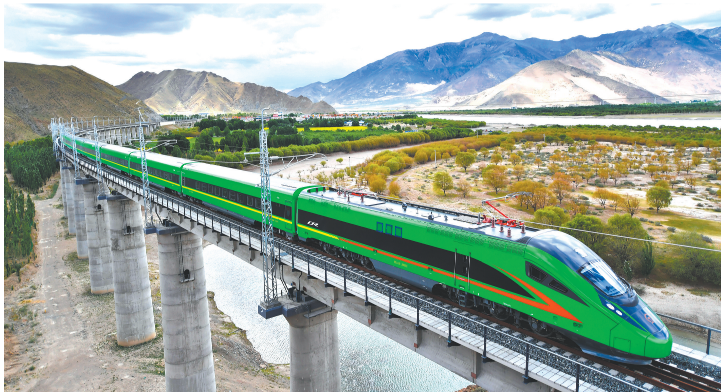
2021年6月25日,全长435公里、设计时速160公里的拉林铁路建成通车,西藏首条电气化铁路建成,同时复兴号实现对31个省区市全覆盖。这是试运行的复兴号列车行驶在西藏山南境内(2021年6月16日摄)。
