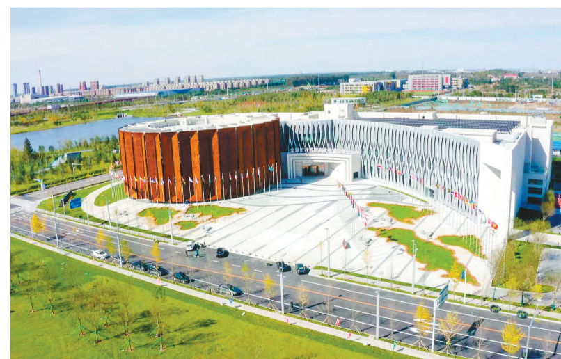
位于沈阳经济开发区的全球工业互联网大会会议中心成为该会永久会址。
