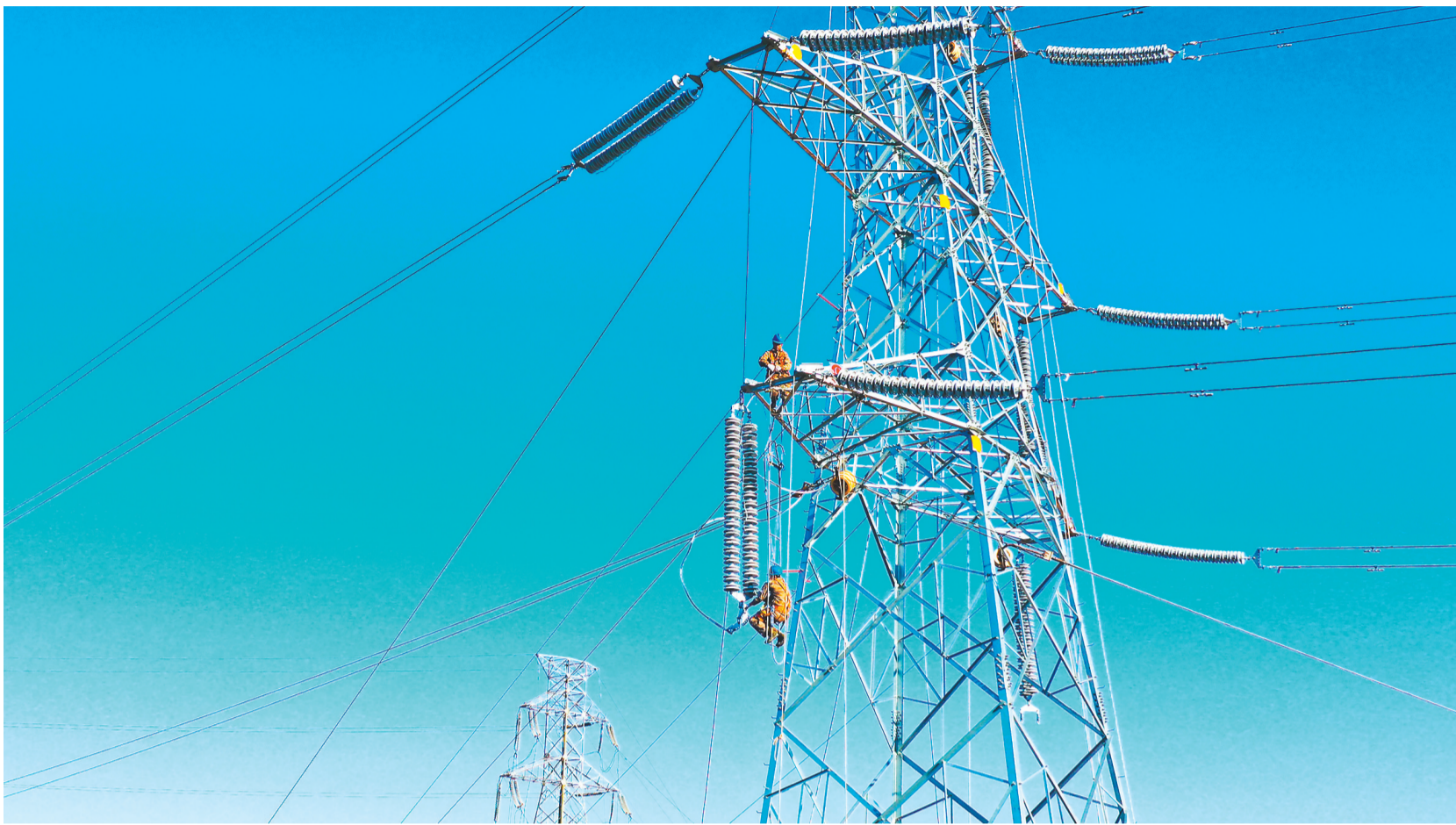
葫芦岛供电公司完成220千伏赢葫一二线迁改工程。
