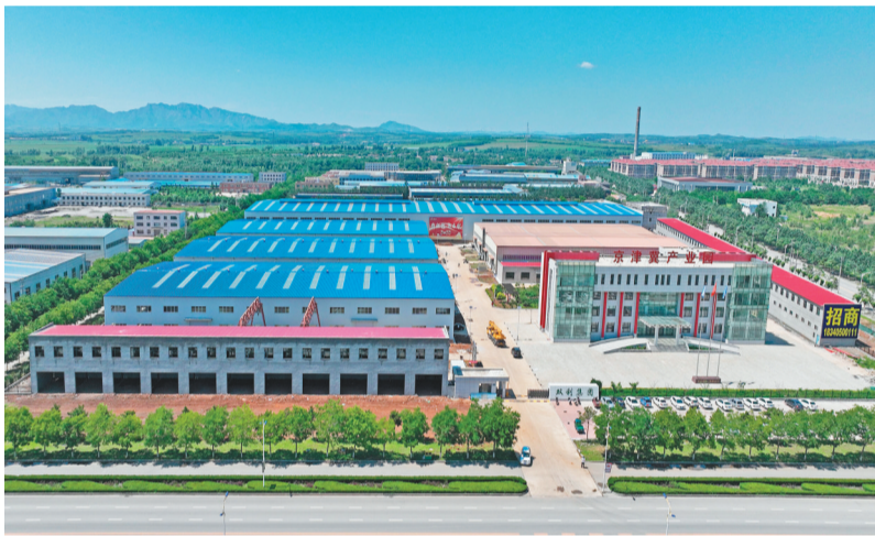
葫芦岛市连山区打渔山京津冀产业园项目。
