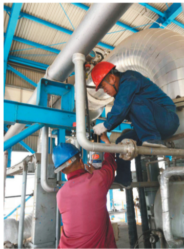
虹京科技有限公司技改项目建设现场。
