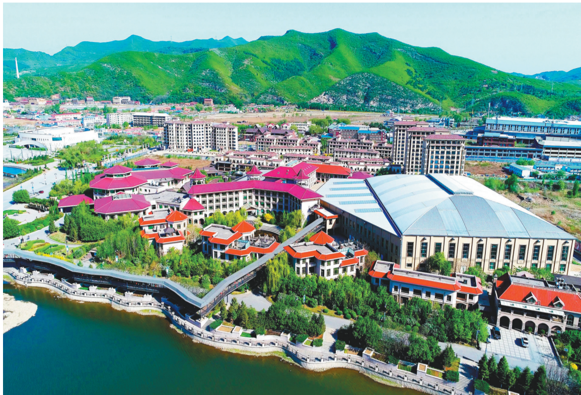
弓长岭区全力打造宜居宜业文明城区,保障百姓安居乐业。
