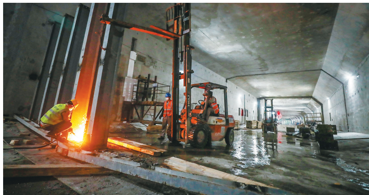
9月29日,工人在大连湾海底隧道内施工。
