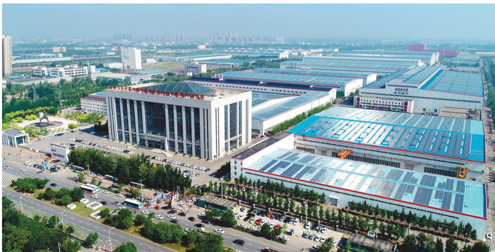
沈阳市铁西区依托北方重工等六大头部企业打造配套产业园。图为重矿机械配套产业园。王宏涛 摄
