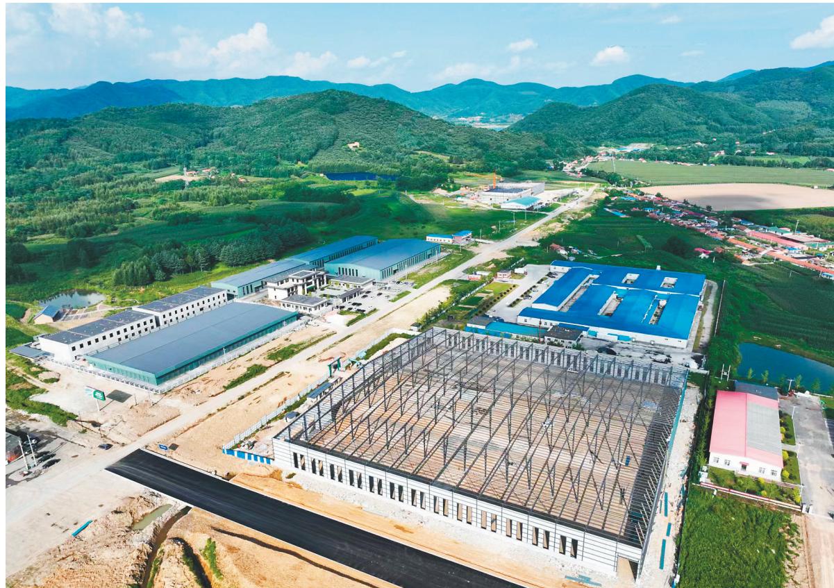
辽宁优创新材料加工项目钢结构主体已完成。 辽宁宽甸经济开发区供图
